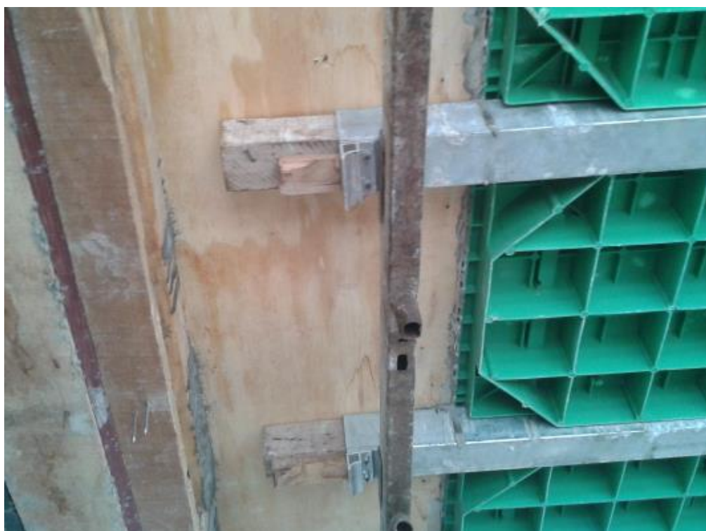
Figura 22 - Barrote de madeira inserido dentro do tubo da LD
