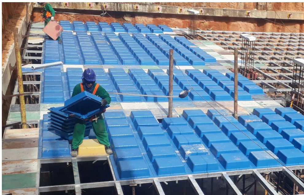
Figura 12 - Fôrmas plásticas sendo posicionadas
