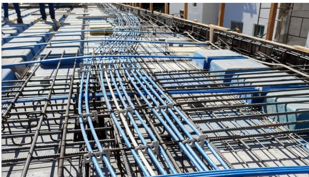
Figura 26 - Laje preparada para concretagem
