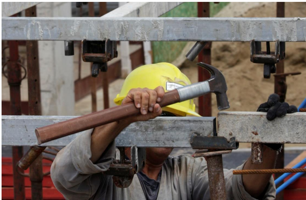
Figura 11 - Próxima linha de LP sendo encaixada na ponteira
