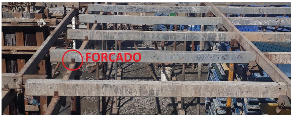
Figura 21 - Forçado apoiando a LD por cima da linha de LPs rebaixada
