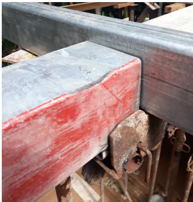
Figura 9 - LD apoiada na LP por meio da Cabeça
