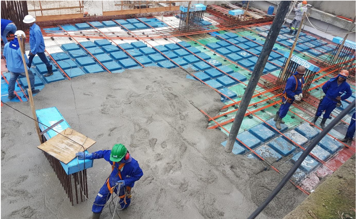
Figura 27 - Momento da concretagem da laje
