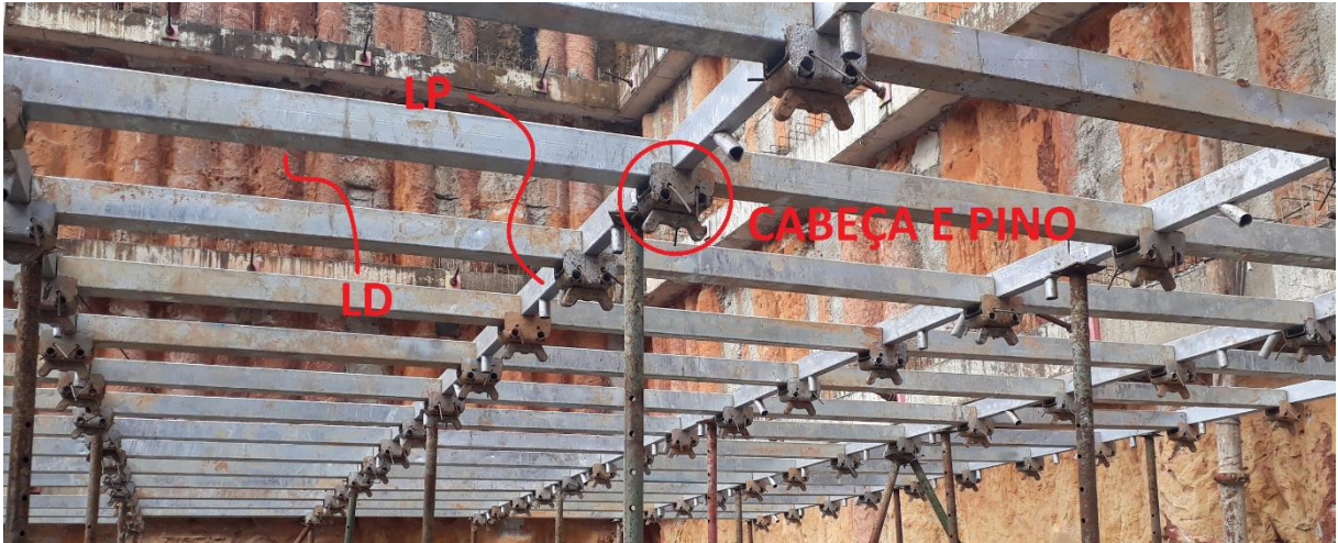
Figura 3 - Principais elementos em obra
