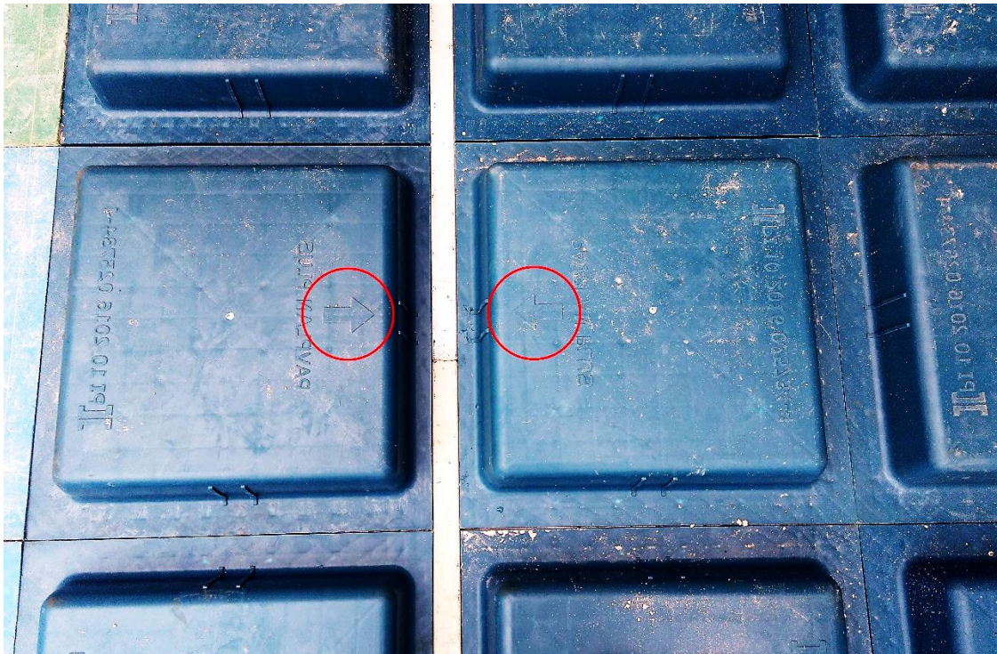
Figura 18 - Cubetas do PavPlus com setas indicando a posição da LP
