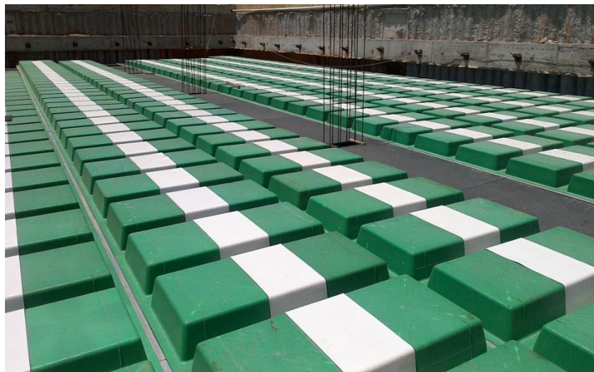
Figura 19 - Tapa nervura para laje nervurada unidirecional
