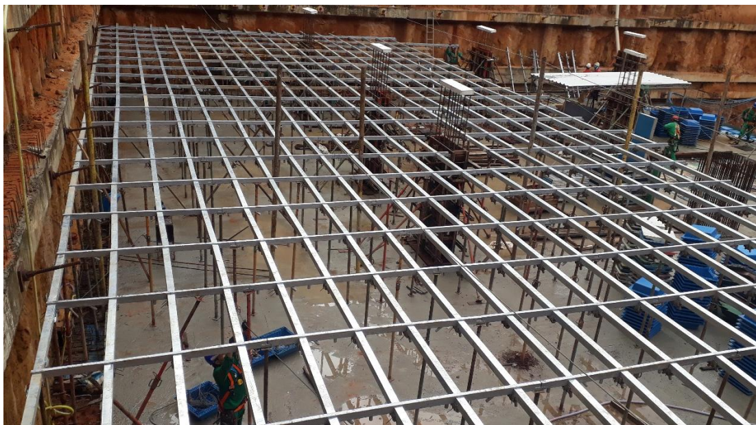
Figura 1 - Cimbramento montado
