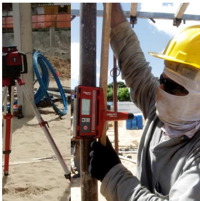
Figura 24 - Verificação do nivelamento do cimbramento
