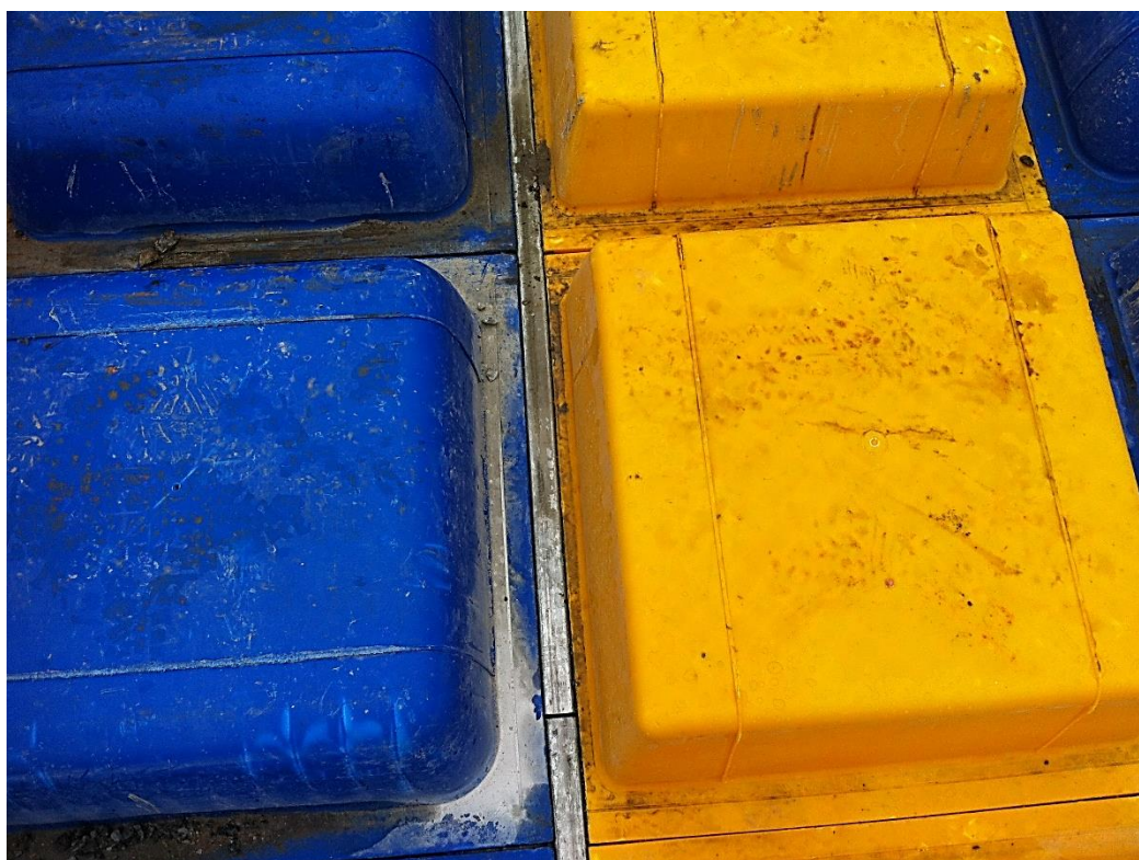
Figura 16 - Cubetas do sistema 80x80 de diferentes tamanhos alternadas. A cubeta amarela à direita possui uma aba menor.
