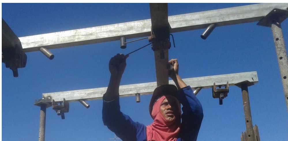
Figura 10 - Encaixe dos ferros de travamento
