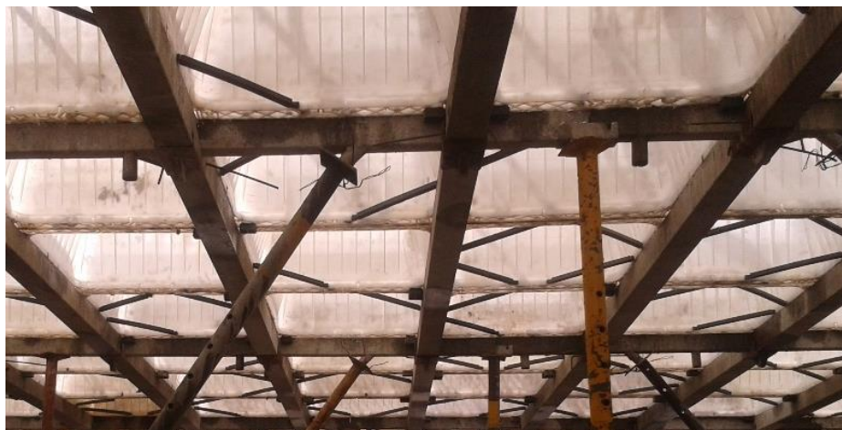
Figura 7 - Escoras encaixadas nos tubos das LPs
