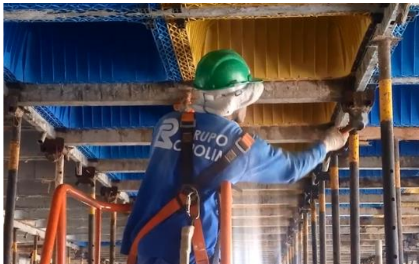
Figura 28 - Desmonte do conjunto cabeça e pino
