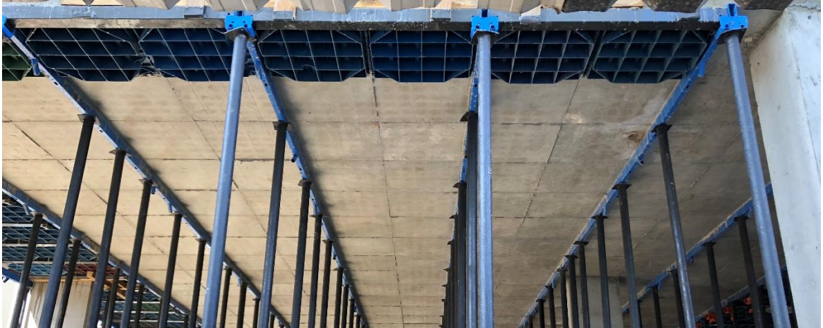
Figura 31 - Laje com escoramento após remoção das fôrmas e LDs
