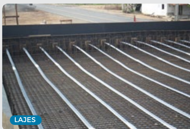
VIGAS (ponte, viadutos, vigas de transição)
