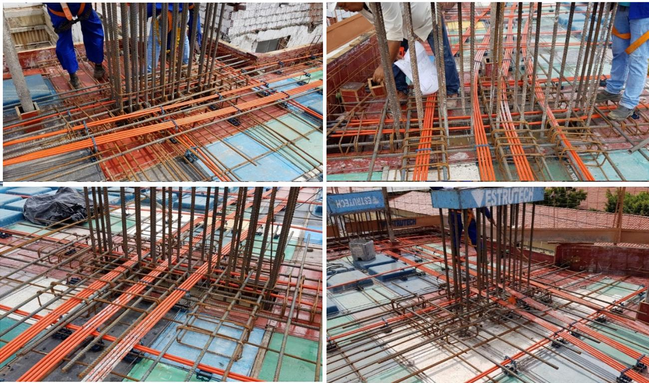
Figura 78: Fotos das armaduras negativas e punção próximas aos pilares P6 e P9 (Em cima) e P10 e P11 (Em baixo).
