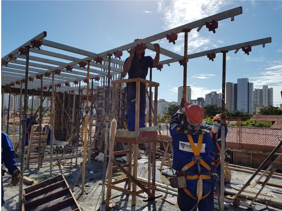
Figura 64: Encaixe das Longarinas de Distribuição.
