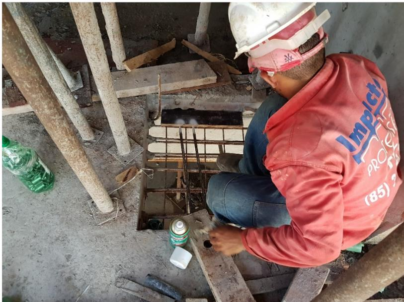
Figura 89: Marcações para medição dos alongamentos.
