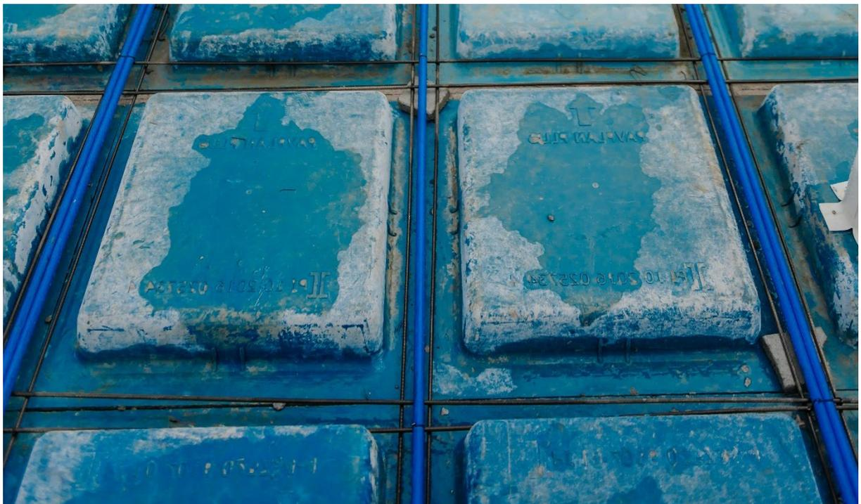
Figura 17 - Aplicação prática da armadura mínima nas nervuras
