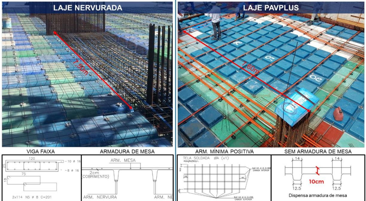
Figura 9 – Comparativo entre o sistema nervurado convencional e o PavPlus.
