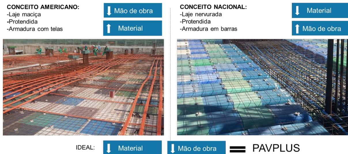
Figura 8 - Sistemas de lajes protendidas.
