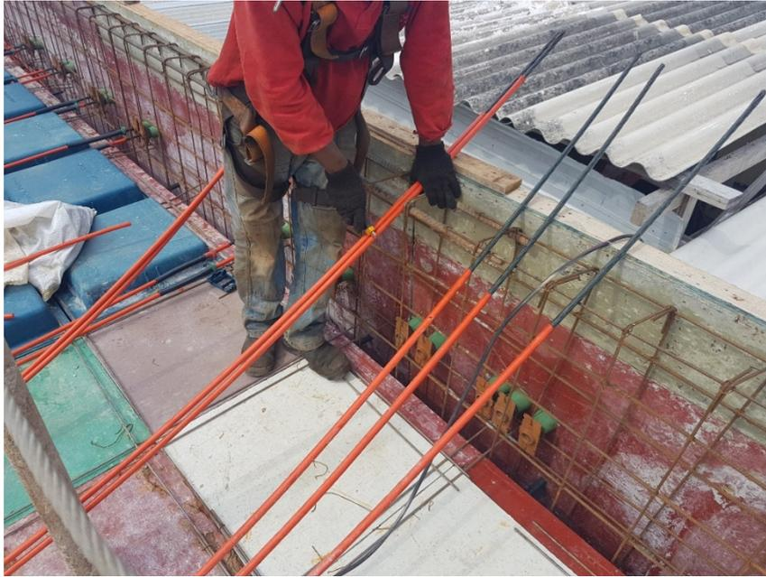
**Figura 80: Cabos sendo cortados para serem posicionados na ancoragem ativa.**
