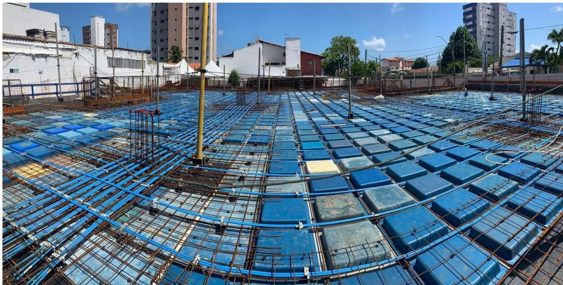
Figura 86: Término da montagem da protensão nos cabos distribuídos.
