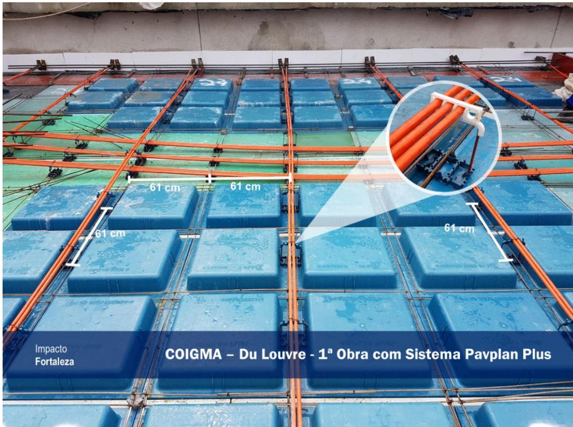
Figura 22 - Laje utilizando o sistema PavPlus do empreendimento COIGMA – Du Louvre
