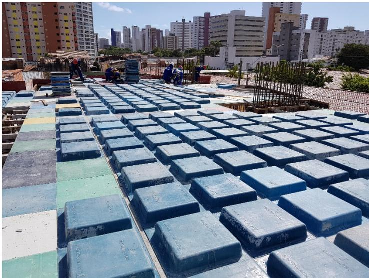
Figura 67: Distribuição de cubetas e plasterits sobre a laje.
