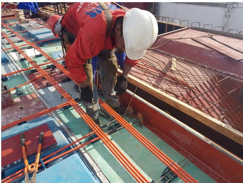
**Figura 82: Ancoragens passivas sendo fixadas e alinhadas.**
