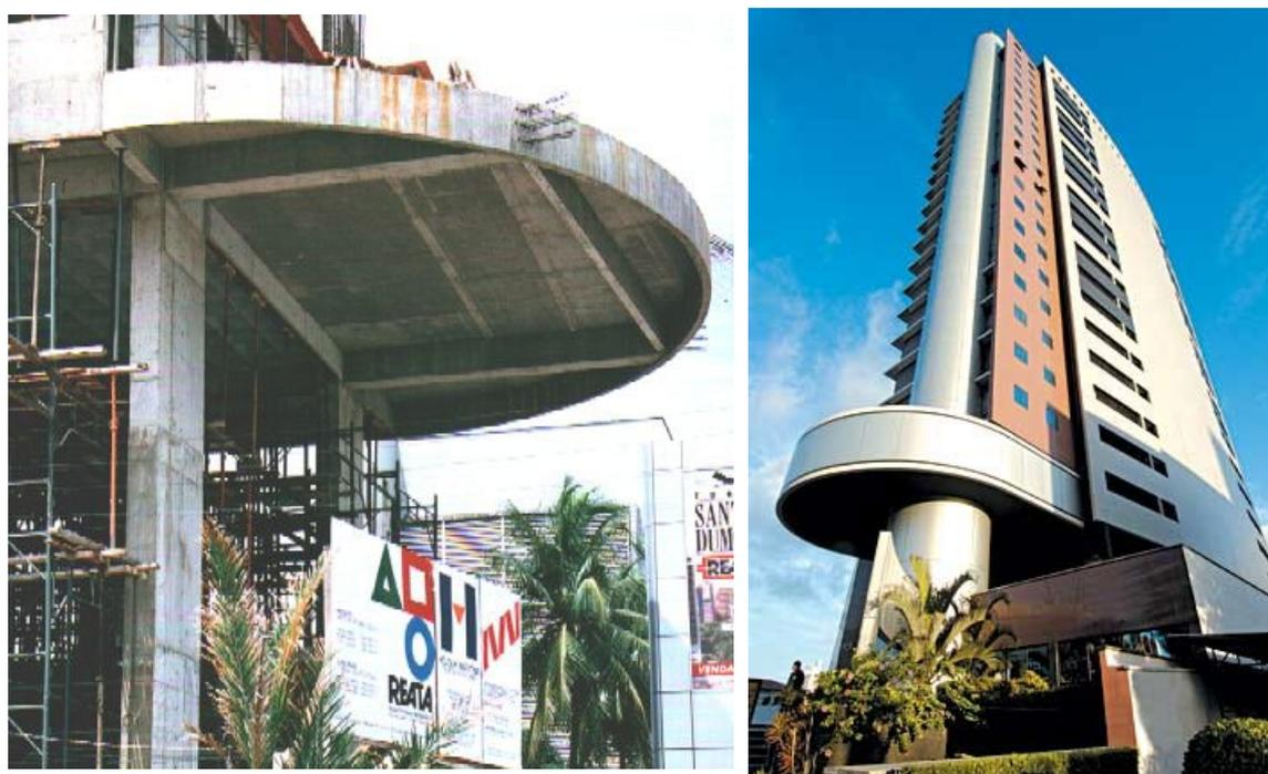
Figura 1 - 1ª Obra do Brasil utilizando protensão não aderente - Torre Santos Dumont, 1997.
