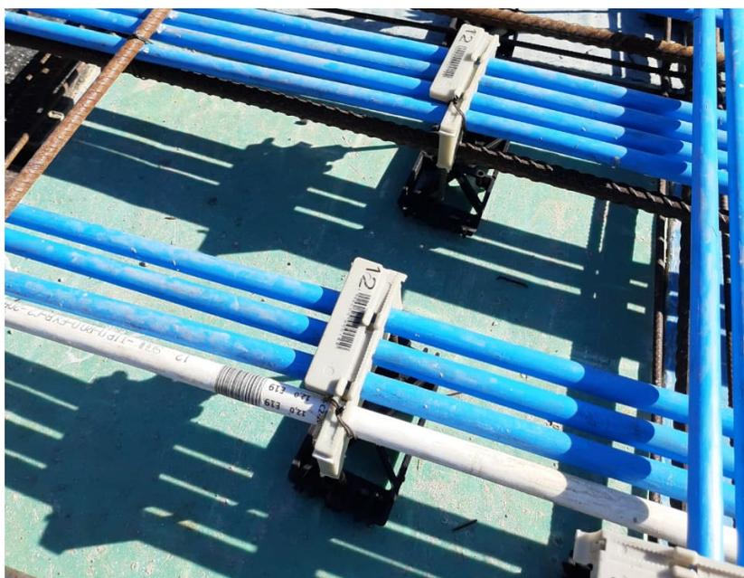
Figura 84: Feixes fixados pelos agarra-cabos nas elevações desejadas.
