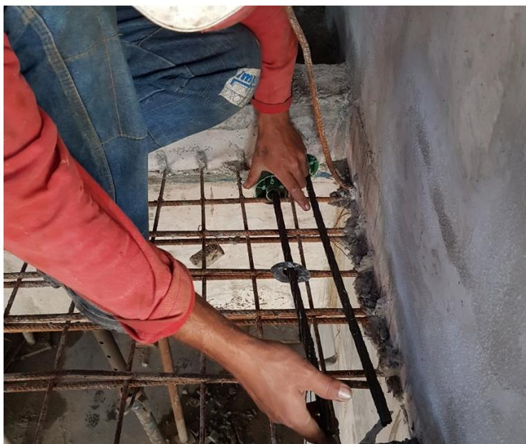
Figura 87: Pocket Forms sendo retirados para que seja realizado a limpeza dos nichos.
