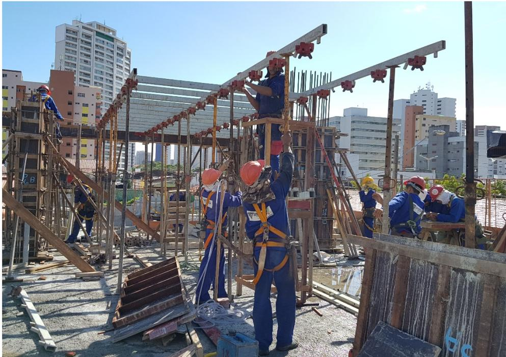
**Figura 63: Suspensão e estabilização das Longarinas Principais.**
