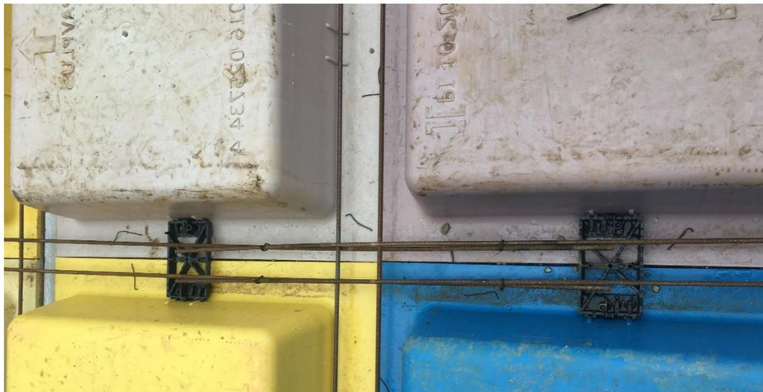
Figura 69: Barqueta presa nas ranhuras das cubetas e recebendo a armadura passiva.
