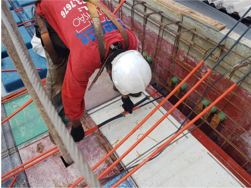
**Figura 81: Cabos sendo posicionados nas ancoragens ativas.**
