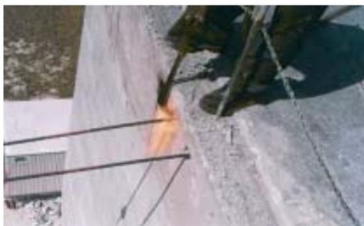
Figura 93: Cabos sendo cortados com auxílio do maçarico.
