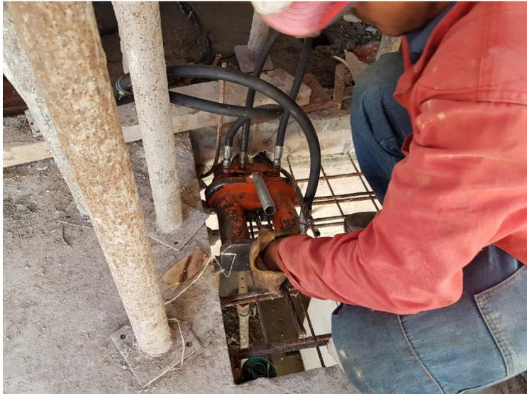
Figura 90: Encaixe do macaco na cordoalha.
