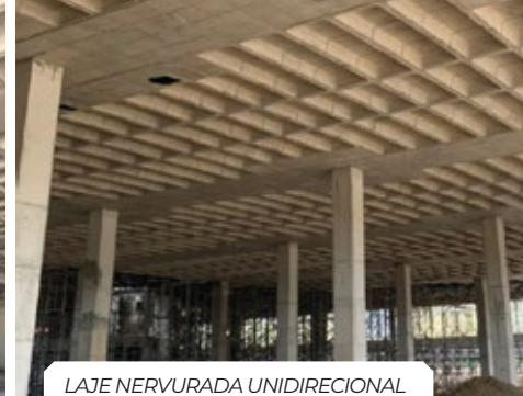
LAJE NERVURADA UNIDIRECIONAL
