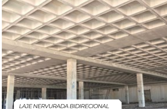
LAJE NERVURADA BIDIRECIONAL
