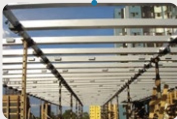
Cimbramento horizontal modularizado de alta performance
