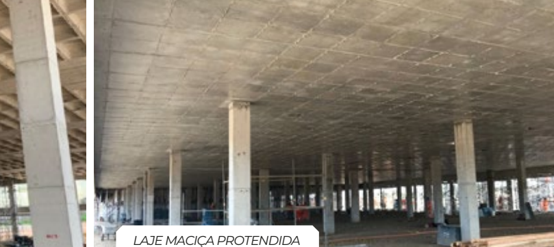
LAJE MACIÇA PROTENDIDA
