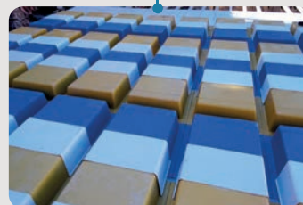
Formação de lajes nervuradas unidirecionais
