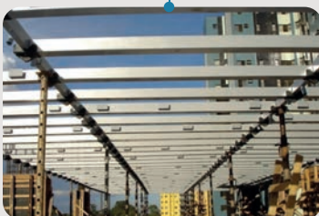
Cimbramento horizontal modularizado de alta performance
