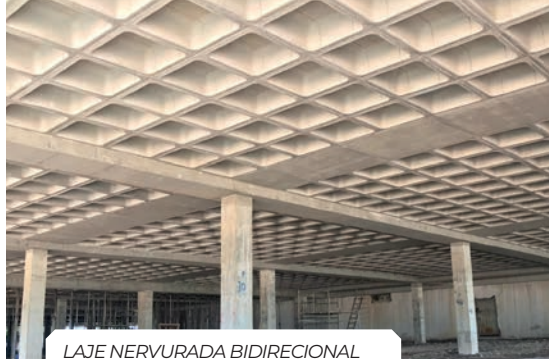
LAJE NERVURADA BIDIRECIONAL
