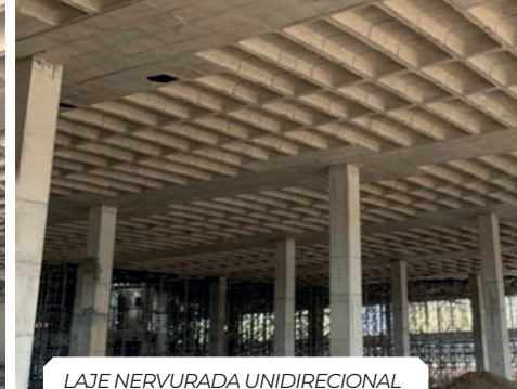
LAJE NERVURADA UNIDIRECIONAL
