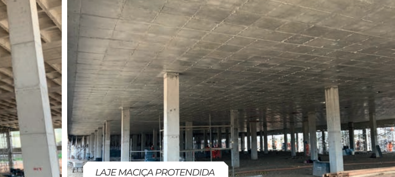
LAJE MACIÇA PROTENDIDA
